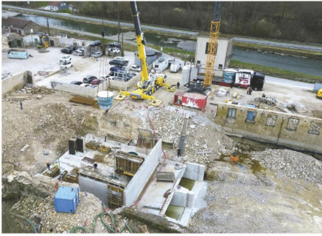
Deux nouvelles turbines du fabricant Watec ont été grutées sur le site de la centrale hydroélectrique de Colombier-Fontaine.
